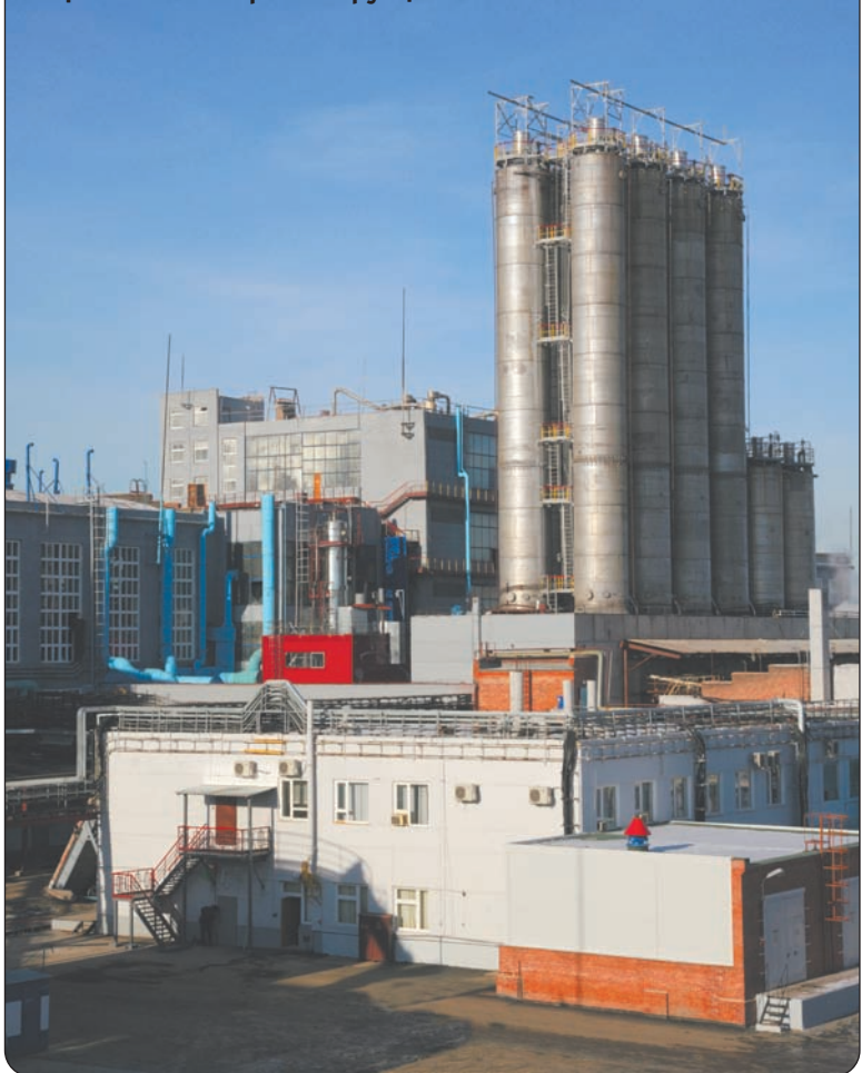
Цех ПВХ после реконструкции
